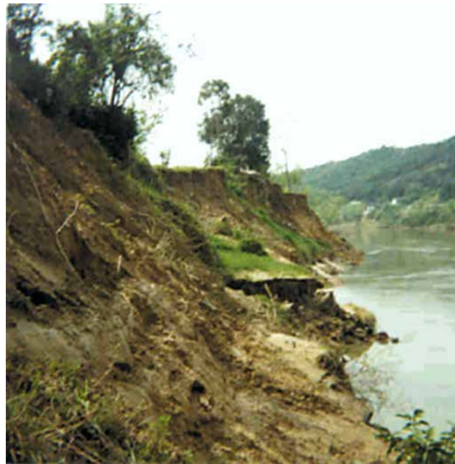
Figura 3.18 – Sedimentos aluviais holocênicos (margem esquerda) do rio Itajaí-açu, próximo da divisa dos municípios de Blumenau e Gaspar. Foto: G. F. dos Santos.
