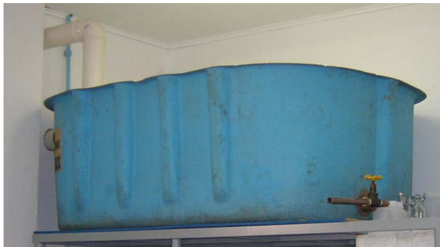
FIGURA 4 - Reservatório de detenção com conduto extravazador e válvula globo na saída para o controle da vazão.
