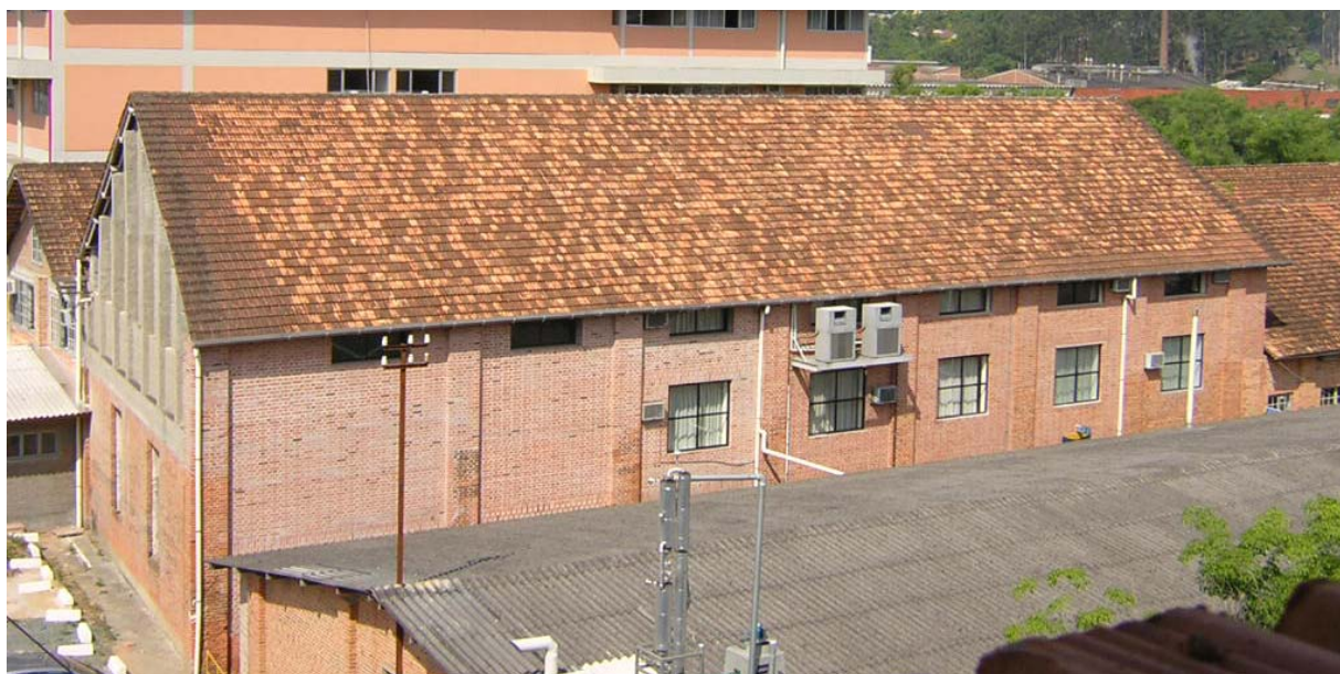
FIGURA 2 - Cobertura do Campus II da FURB e sistema de captação onde é coletada a água para o reservatório de detenção.
