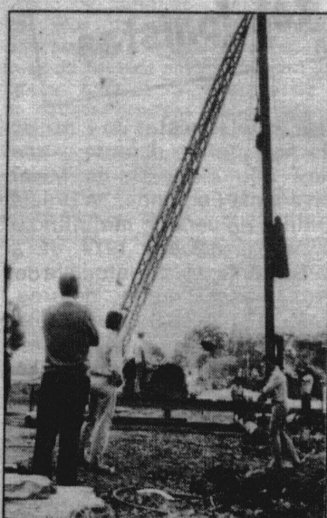
Foram iniciadas na última semana, conforme anunciamos na edição número 23 do Vitrine, as obras da nova biblioteca da Furb. Na foto, vemos a colocação da estaca inicial.
