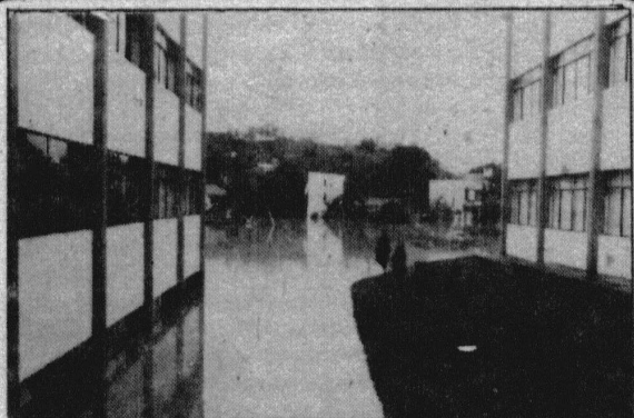
Os blocos D, E, F e G tiveram o primeiro pavimento submerso.
