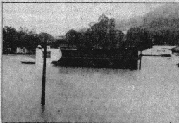
Cantina e sede do DCE no ponto máximo da enchente.
