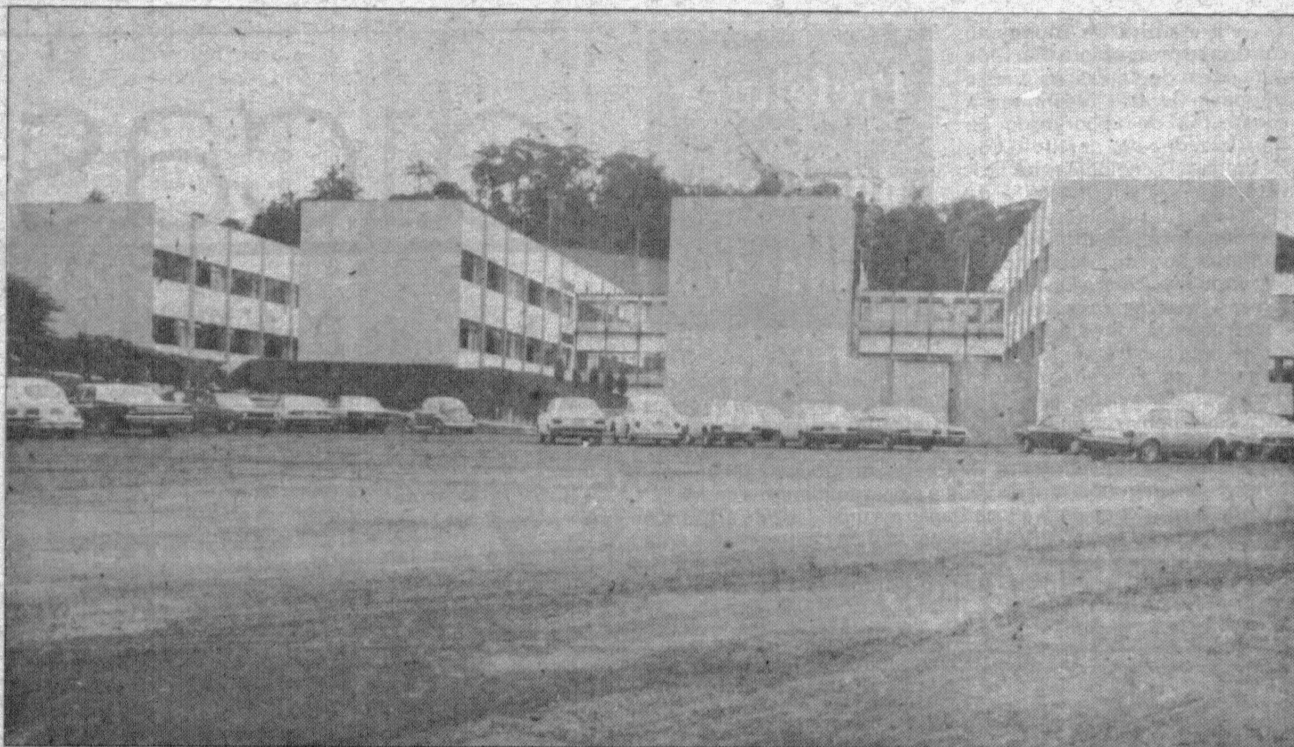
Os professores agora dispõem de estacionamento asfaltado. Em dias de chuva não haverá mais lama.
