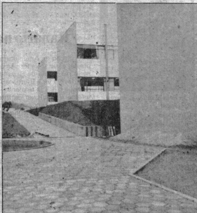
Foram construídos acessos para pedestres.
