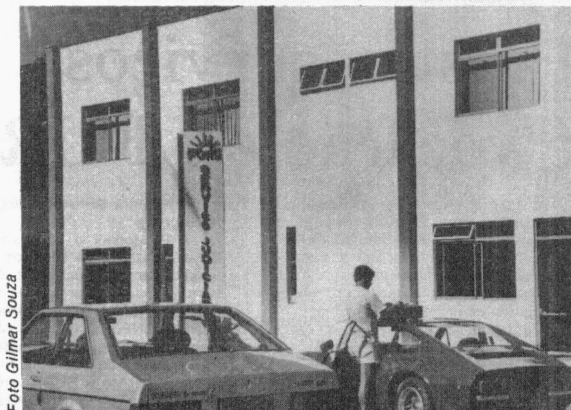
Foto: Gilmar Souza O novo prédio do Serviço Judiciário
