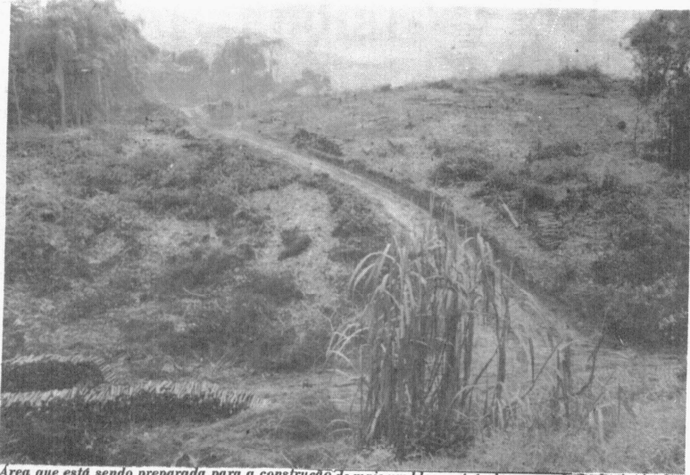
Área que está sendo preparada para a construção de mais um bloco, atrás do campus I.
