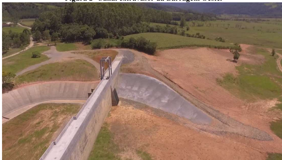
Figura 2- Canal extravasor da Barragem Oeste.
