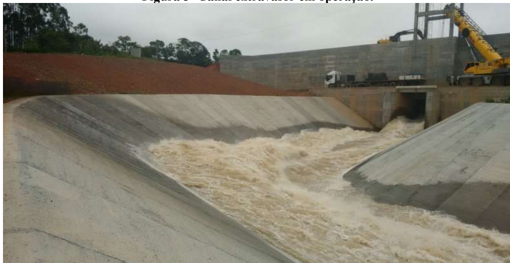
Figura 3- Canal extravasor em operação.
