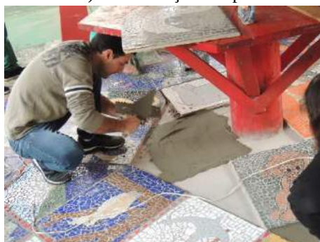
e) Aplicação das placas no piso
