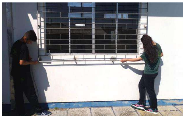
Figura 1: Medição do contorno externo da construção, utilizando-se de uma trena.
