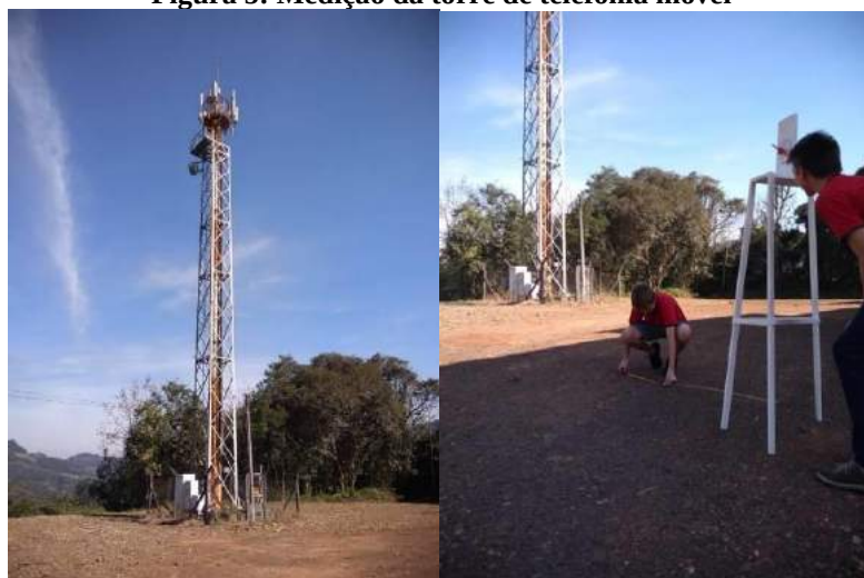
Figura 5: Medição da torre de telefonia móvel
