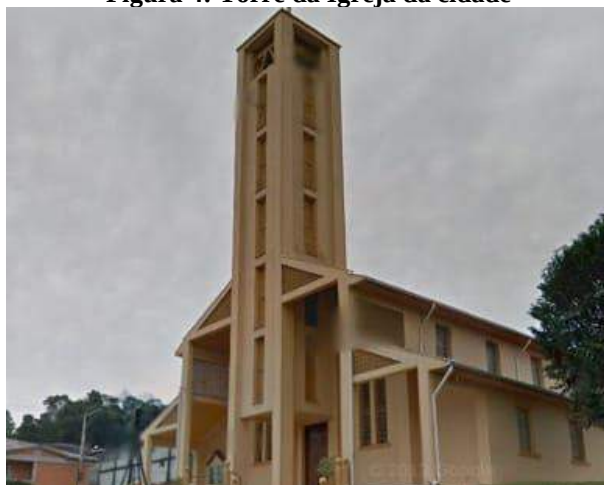
Figura 4: Torre da Igreja da cidade
